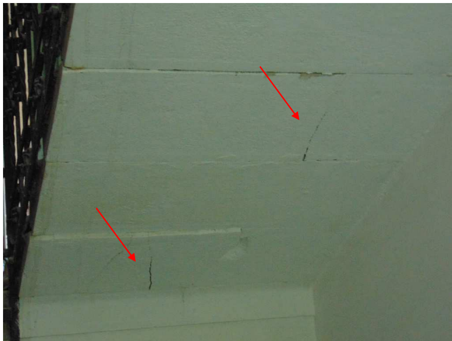
A lebegő lépcső átrepedt kőkonzoljai
